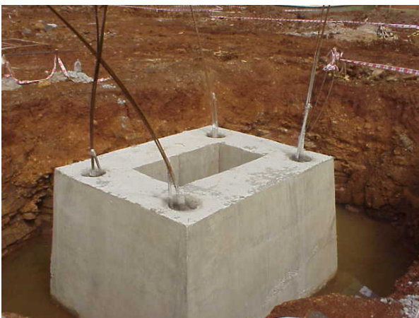
Figura 4. Base aislada con 4 anclajes.
