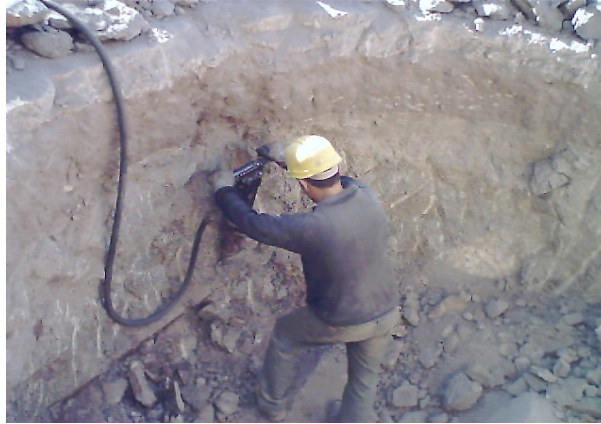
Figura 7. Vista de la excavación de una base.
